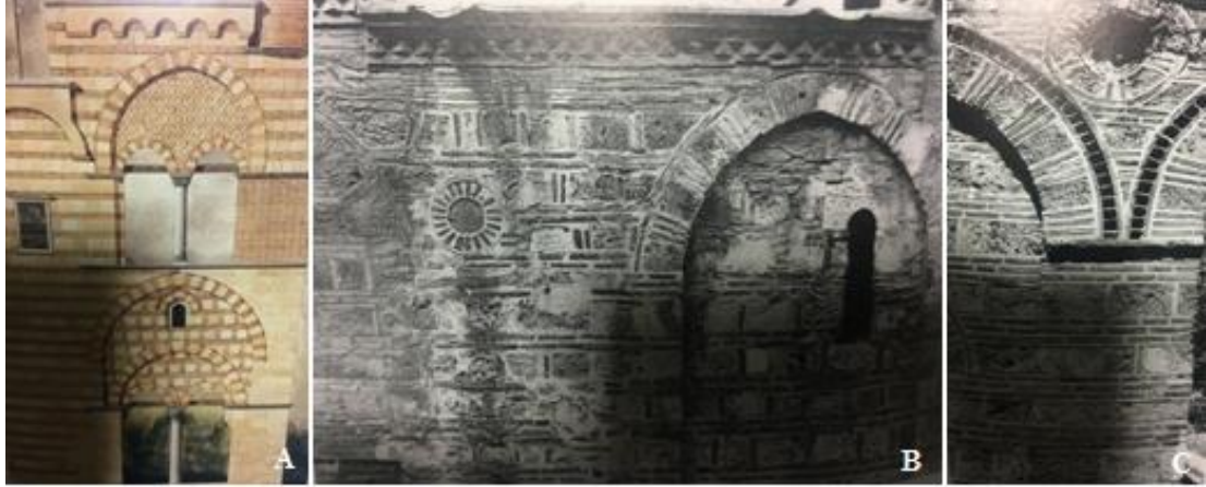
Fotoğraf 14. Tabhaneli Camilerde Almasık Duvar Örgü Tekniği A. Bursa Hüdavendiğar İmaretı (Kuban 2007), B. Bursa Orhan Gazi Cami (Emir 1994), C. Yenişehir Postinpüş Baba Zaviyesi (Emir 1994)
